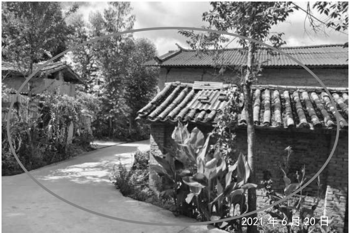
现场踏勘照片地块三
