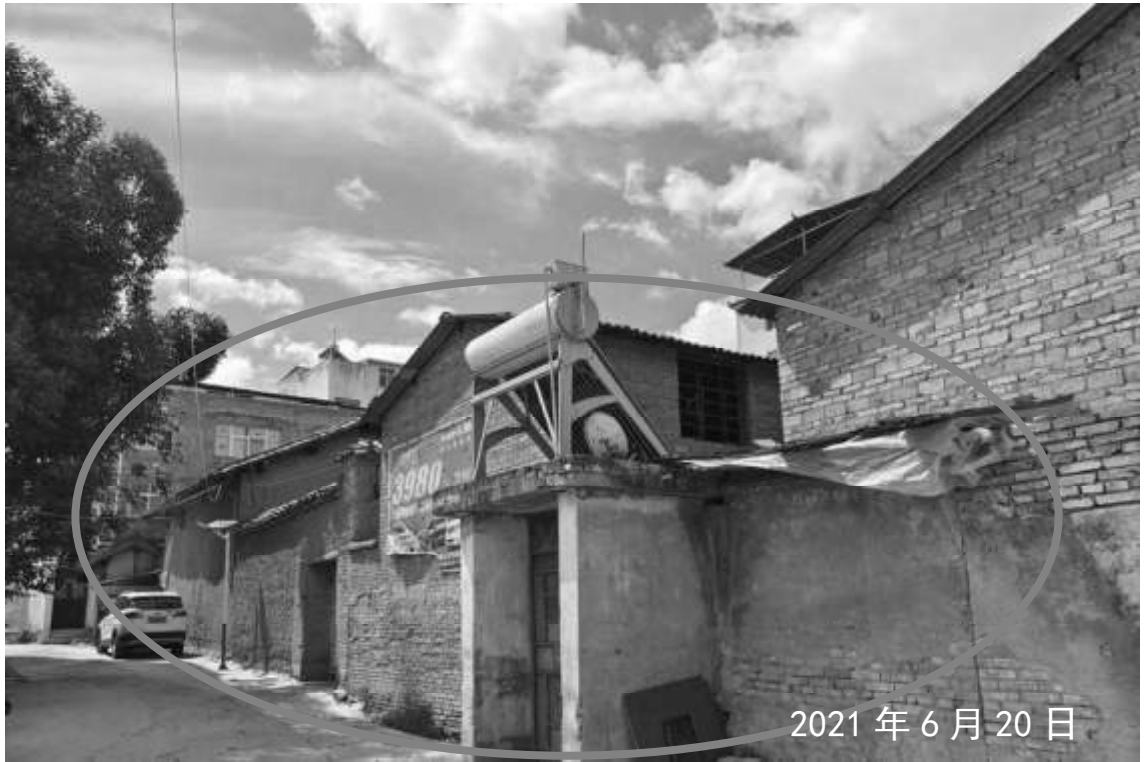
现场踏勘照片地块九
